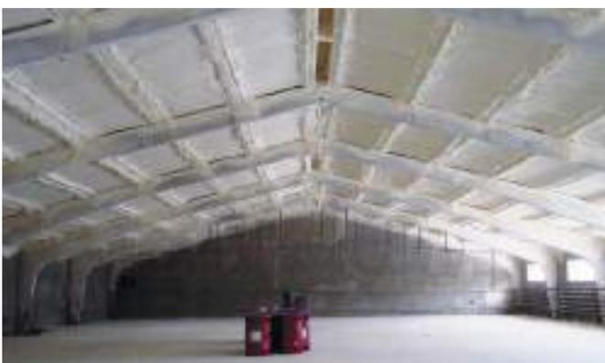
Пенополиуретан (ППУ) относится к группе газонаполненных пластмасс или, как их еще называют, пенопластов. Образование пенополиуретана осуществляется при реакции двух жидких компонентов А и Б – полиизоцианата и полиола, в результате которой происходит синтез полимера: вспенивание и отверждение.
