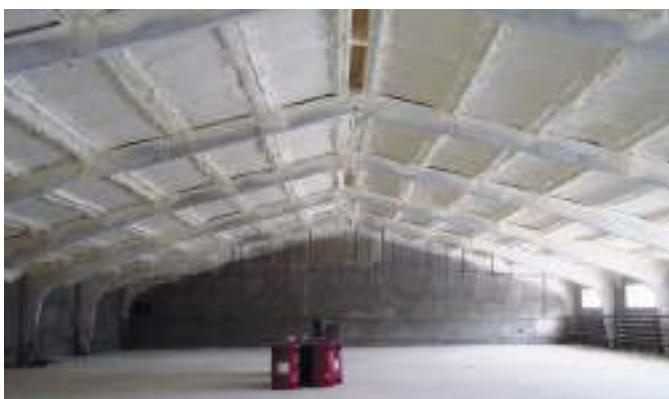
Пенополиуретан (ППУ) относится к группе газонаполненных пластмасс или, как их еще называют, пенопластов. Образование пенополиуретана осуществляется при реакции двух жидких компонентов А и Б – полиизоцианата и полиола, в результате которой происходит синтез полимера: вспенивание и отвердение.
